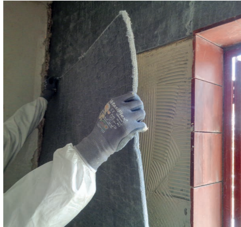
← Her sættes isoleringsmætter af aerogel op på væggene i PH's hus.
